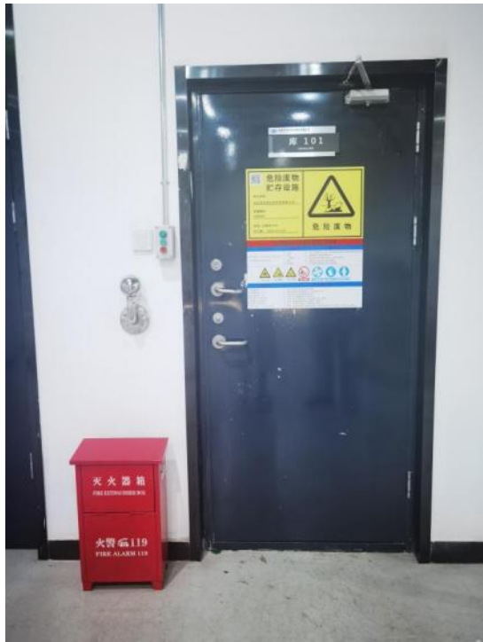
危废暂存间外部
