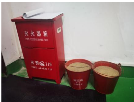
危废暂存间内部
