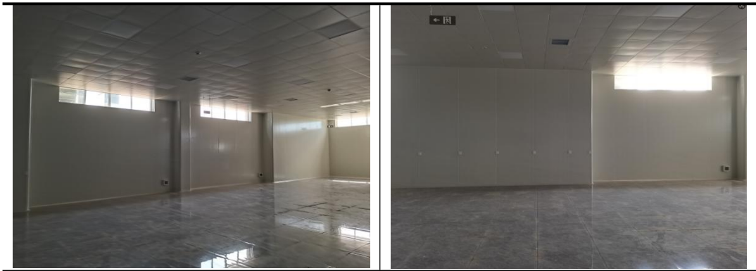
图 5 厂房内部现状照片
