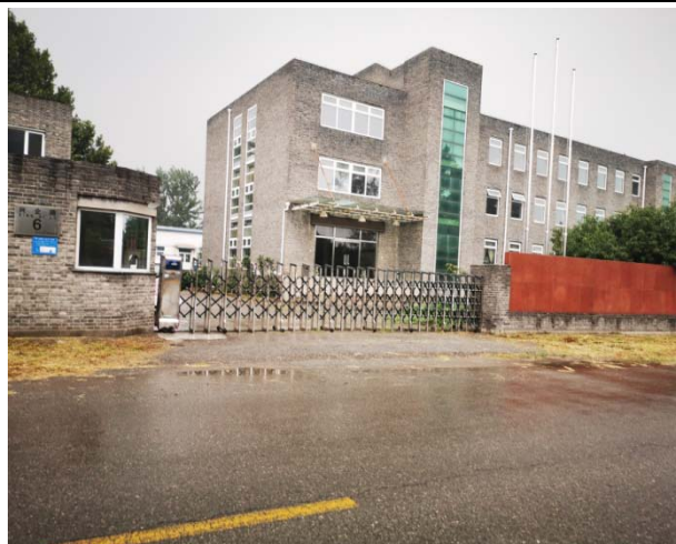
南侧现状-兴企路、焊机制造公司
