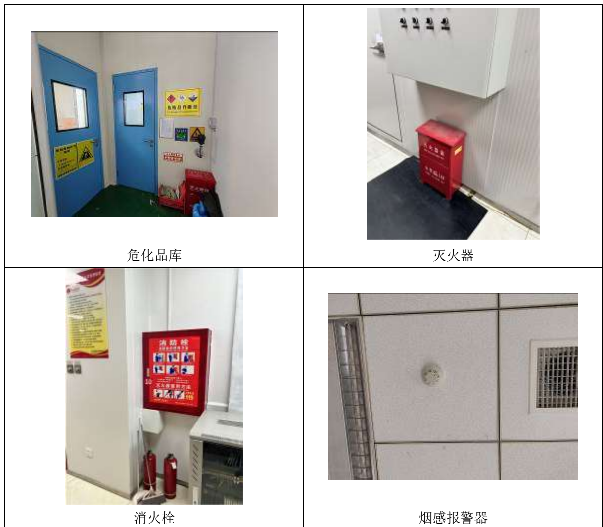
图 3-5 环境风险防范措施现状照片
