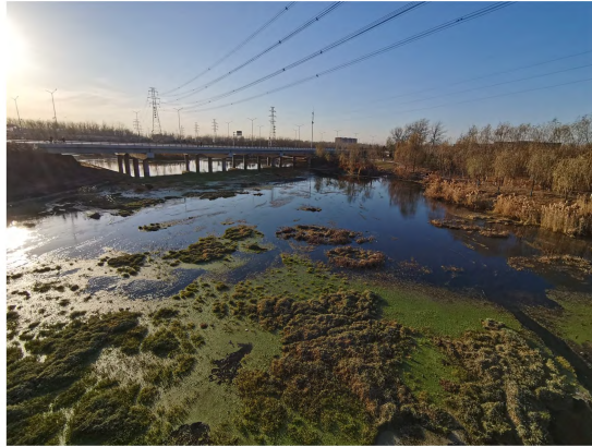
图 1 萧太后河现状照片
