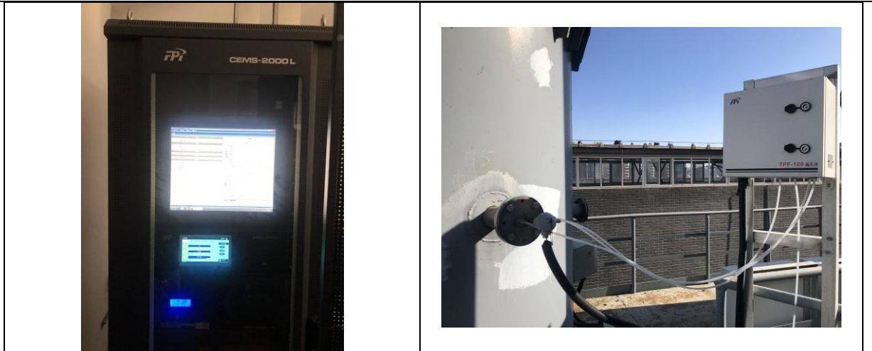
图 3-5 烟气在线监测装置照片
