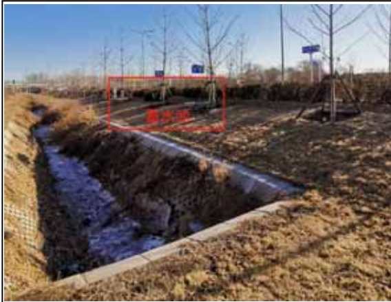
1#明渠及蓄水池
