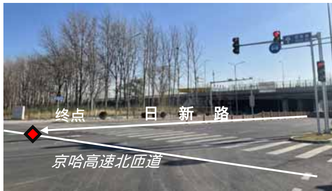
终点-京哈高速北匝道
