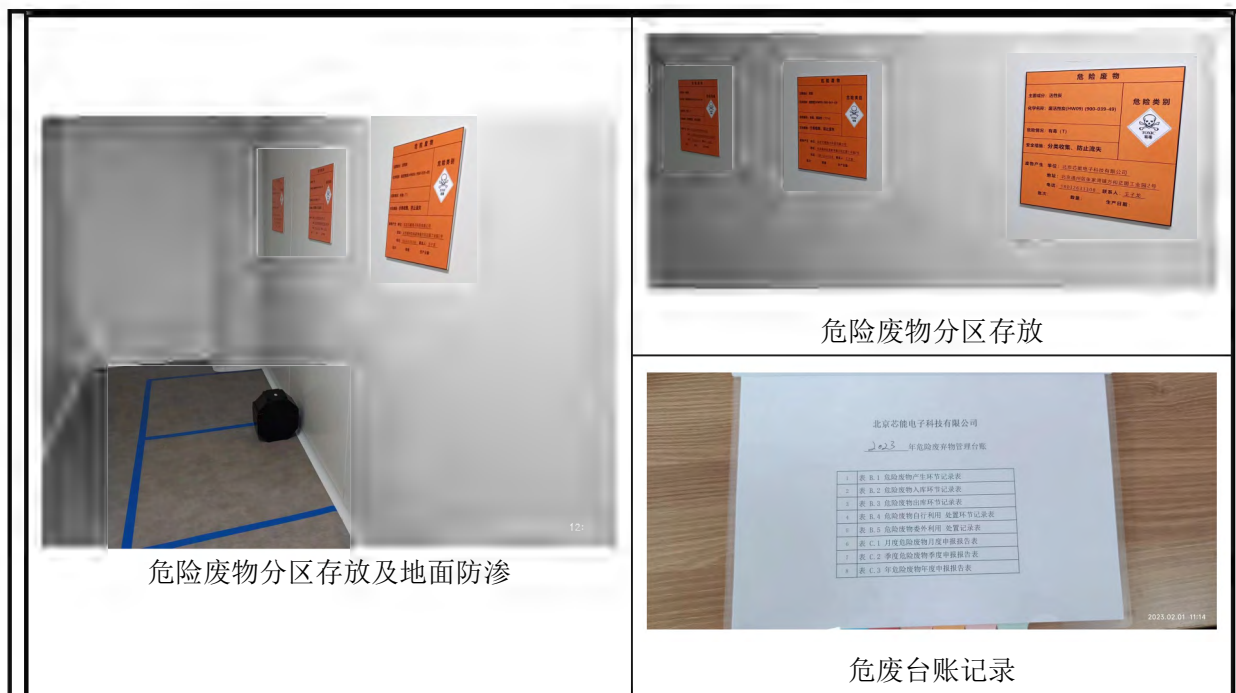
图 8 危废暂存间现状照片
