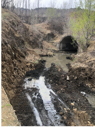
放水后泄洪洞出口
