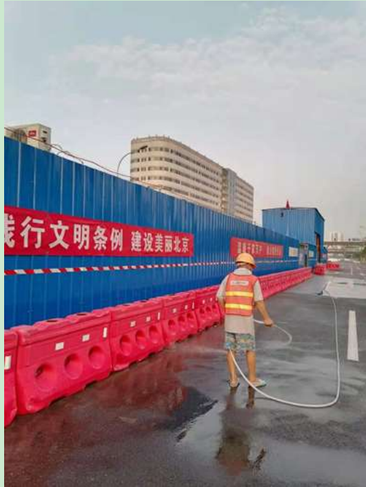
施工围挡、洒水抑尘、封闭罩棚
